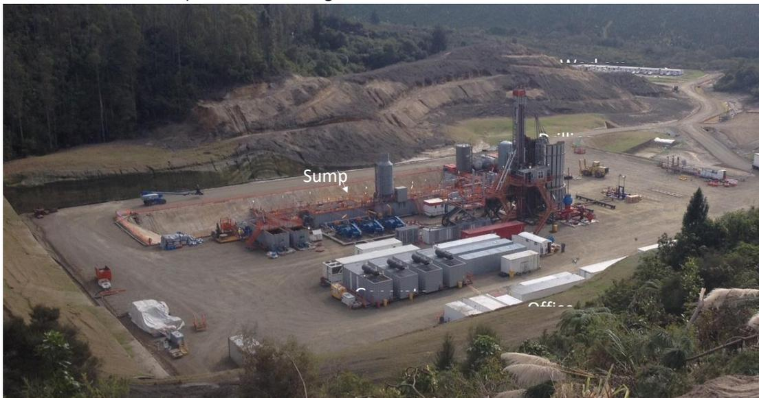
**PHOTO 2 : DISPOSITION TYPIQUE DE LA PLATEFORME DE PUITS ET DES PUISARDS (SOURCE : JACOBS, 2019)**
